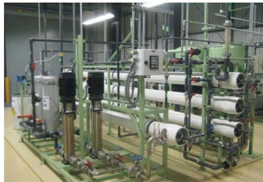
逆浸透膜を用いたろ過装置
