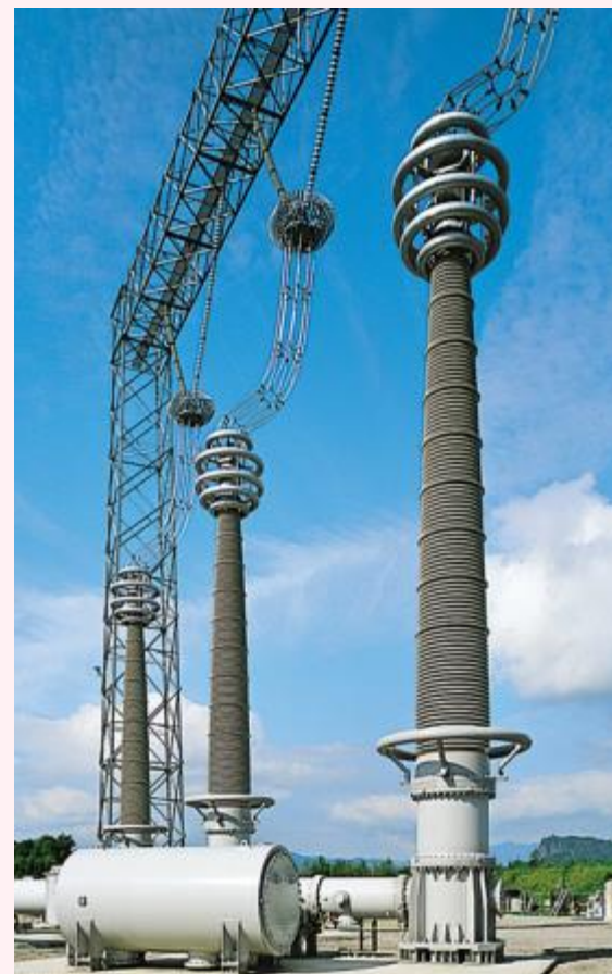
変電用ガスブッシング
