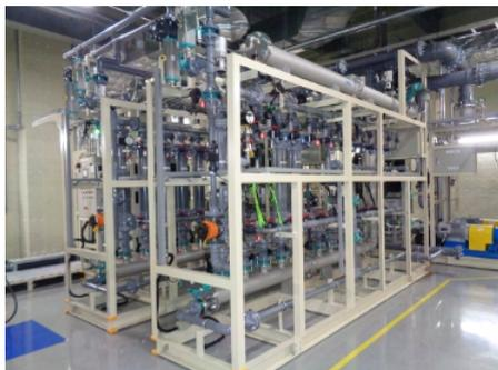
再生水処理装置（NCDK富士吉田工場）
