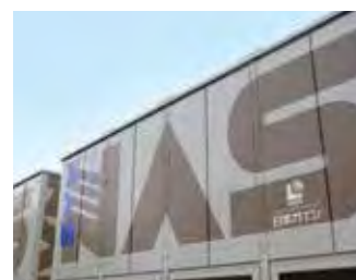
NAS電池は国内および海外ですでに約200カ所の稼働実績があります
