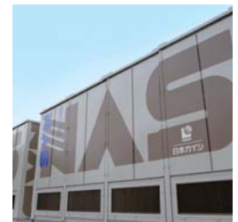
世界で初めて実用化したメガワット級の電力貯蔵システム「NAS電池」
