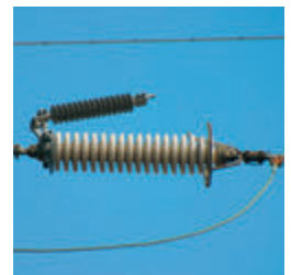
停電の減少に大きく貢献する避雷装置などの 「送電用機器」
