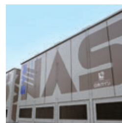
世界で初めて実用化したメガワット級の電力貯蔵システム「NAS®電池」
