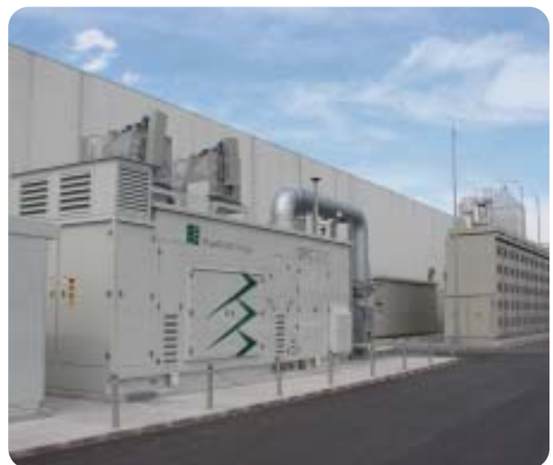
燃料電池(手前)とNAS®電池(奥)併用システム
