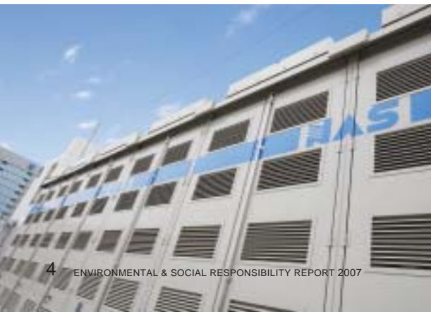
日本ガイシ AC 工場に設置された 1,500kW NAS®電池
