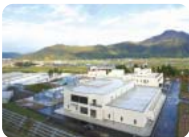
浄水設備全景
