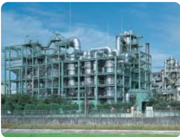
下水処理プラント
