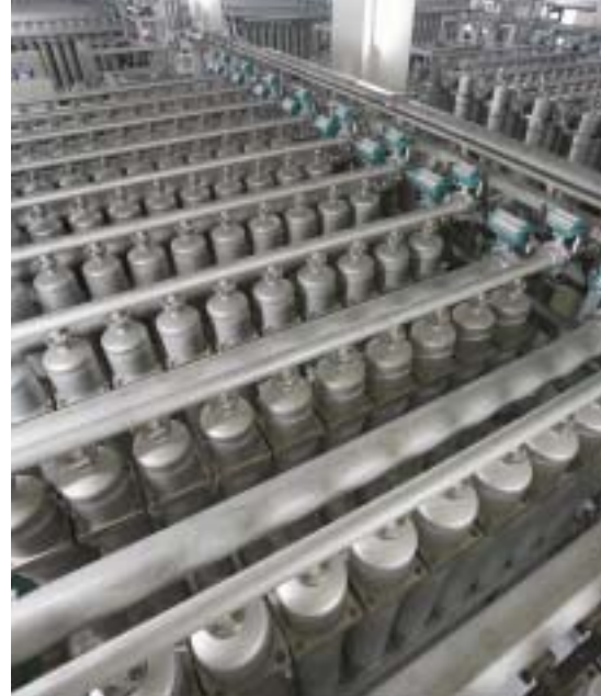
セラミック膜エレメント 1,800本を備えた浄水設備
