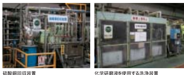
硫酸銅回収装置 化学研磨液を使用する洗浄装置
