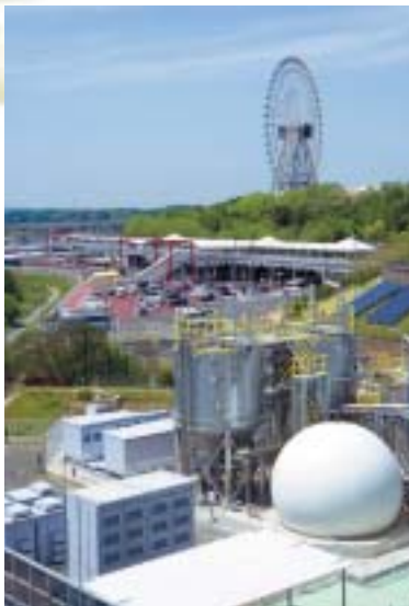
新エネルギープラントのNAS ® 電池(左下)とメタン発酵システム(右下)
