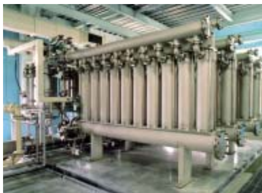
2001年7月に東京都水道局から初めて受注した大型セラミック膜浄水システム
