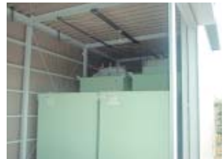
PCB使用機器保管庫( 知多事業所 )
