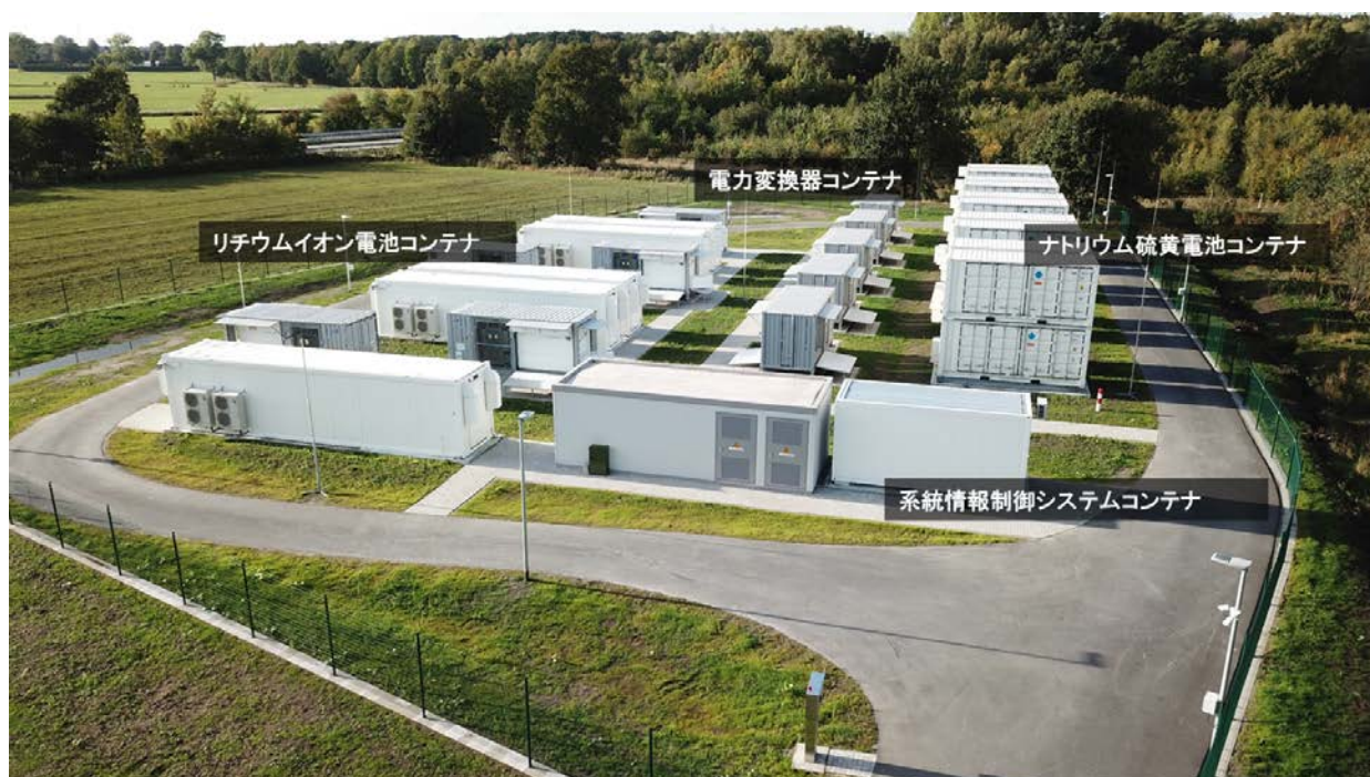
写真 実証運転を開始する大規模ハイブリッド蓄電池システム
