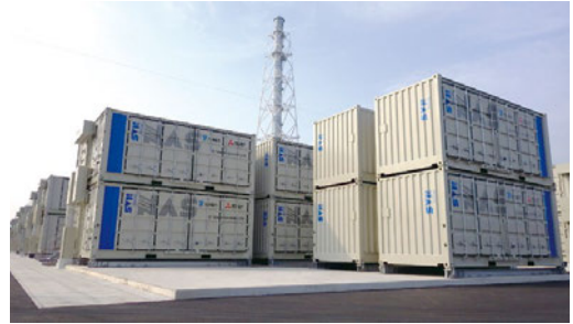
新たに開発したコンテナ型NAS ® 電池252台を納入。九州電力管内では、太陽光発電を中心に再生可能エネルギーの普及が急速に進んでいる
