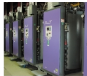
小牧事業所で新たに運転を開始したLNGボイラー。
