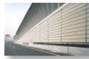
陶磁器屑でつくられたセラミック吸音板
