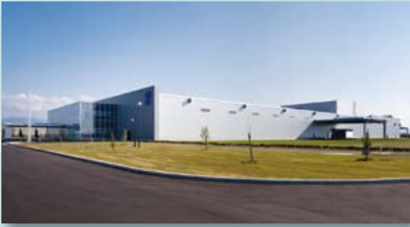
最新鋭の生産ラインを導入した石川工場(石川県能美市)
