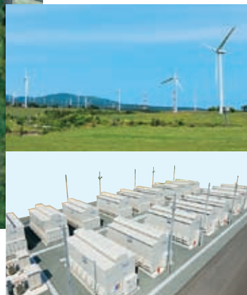
現在、二又風力発電所 （青森県六ヶ所村）で稼 働中のNAS®電池。
